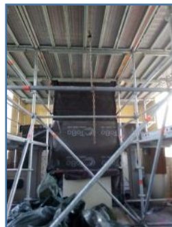
Baugerüste in der Kirche
