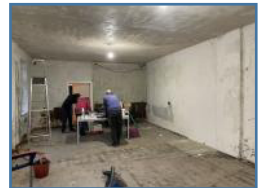
Es wurde viel geschafft. Hier nur zwei fertige Räume.
